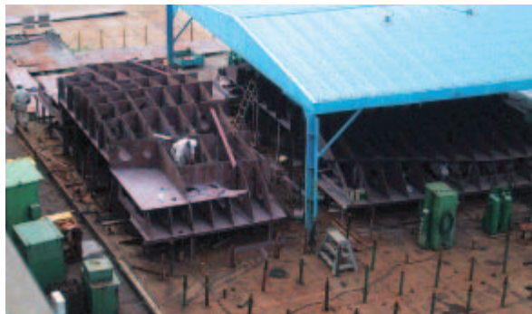
建造が始まった船体部
