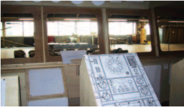
総合管制室内部の写真
