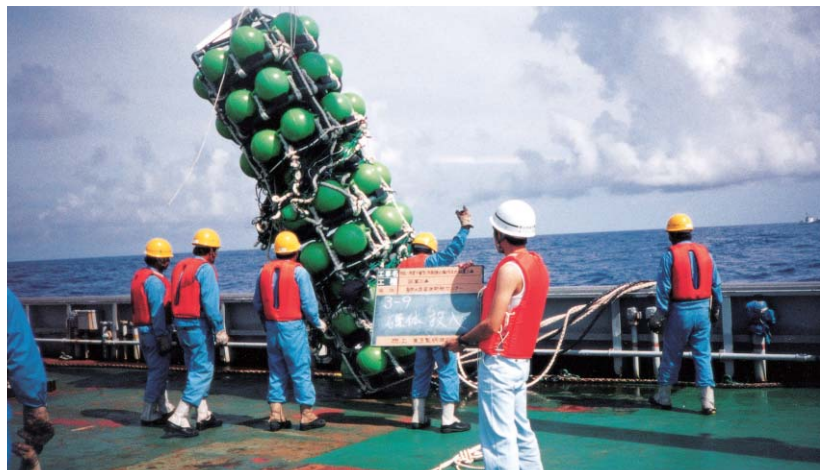
中層型浮魚礁の設置工事(平成11年度)
