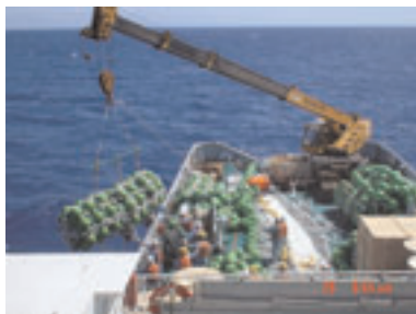
中層型浮魚礁の設置工事
