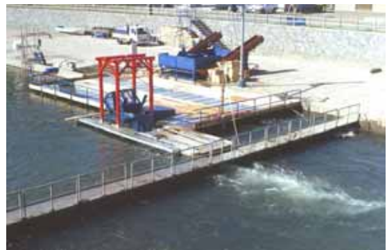
図9. さけ・ますの捕獲施設は、親魚を効率的に捕獲槽に誘引するように、遡上入口を魚が到達できる最上流端に配置し、入り口の流量を増やして瀬をつけるなど工夫されている(石狩川支流千歳川の捕獲場)。
