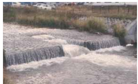
図10. 遡上魚が魚道の入り口を見付けやすいよう、「呼び水」を注ぐ構造の魚道が多いが、この場合は遡上水路の脇から水を落とすという簡単な構造でその効果を高めている(止別川の落差工に付設された魚道)。
