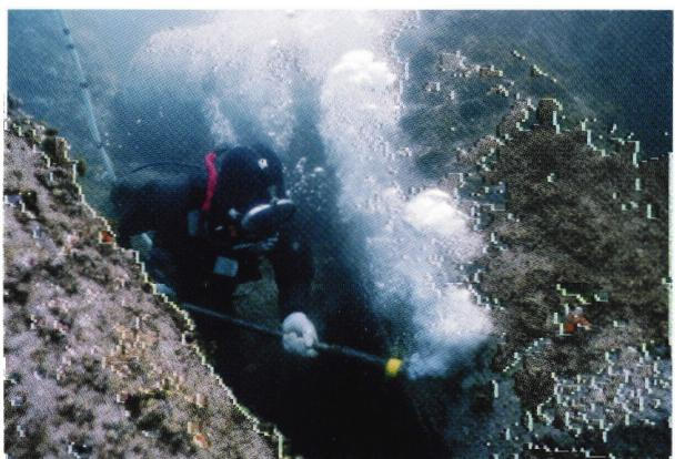
写真5 エアージッパーによる基盤清掃
