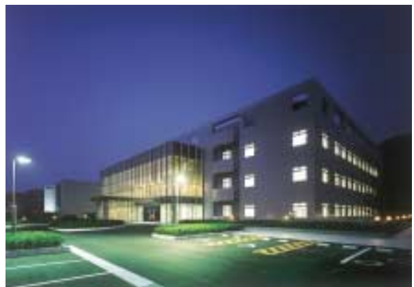
外観南西面夜景
