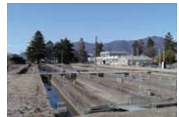
屋外池から共同実験室を望む
