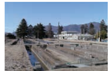
屋外池から共同実験室を望む
