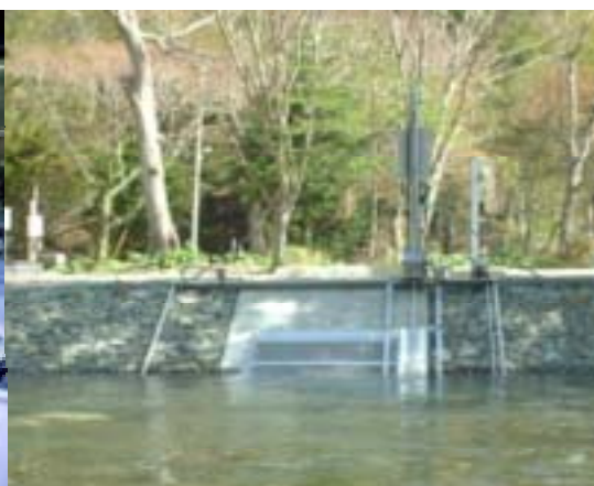
写真2 河川水取水設備。
