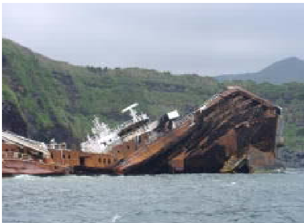
写真3. ファル・ヨーロッパ号の船首部分。解体工事が始まっているものの、完了までに数年はかかるとの話。船体はすっかりさび付いてしまっている。
