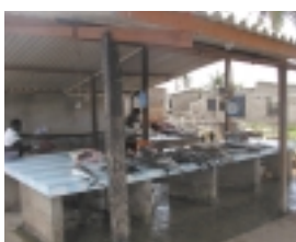
バナトラ漁港敷地内の鮮魚販売所 （スリランカ、カルタラ県）
