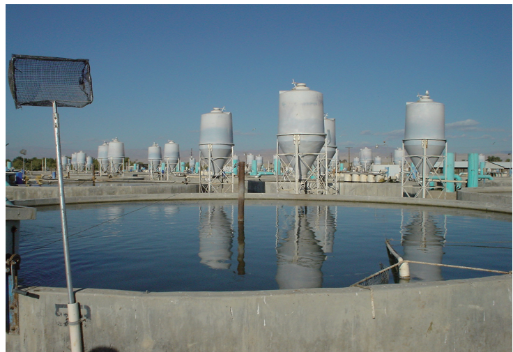
写真3 砂漠の中に作られた閉鎖循環式シーバス養殖施設（カリフォルニア州）
