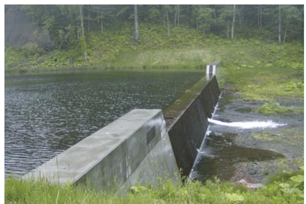
写真3. 堰堤でせき止められた川。
