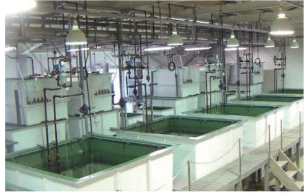
写真. 屋島栽培漁業センターの閉鎖循環飼育システム.
