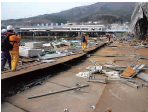
地盤が約70センチ沈下した新市場の岸壁 (大船渡市)
