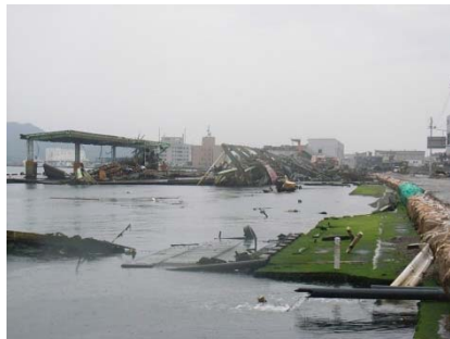
写真1 震災で地盤沈下した気仙沼魚市場
