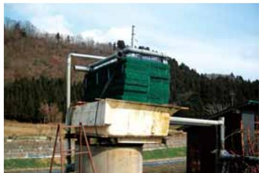
写真3 変更後の曝気(ばっき)装置
