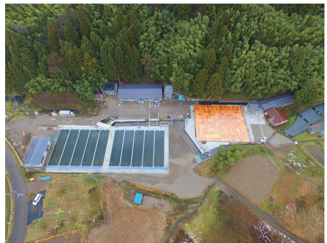
図5. 栢川ふ化場（上：改修前、下：改修後）
