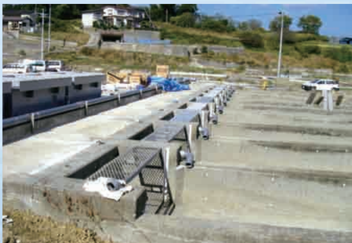
復旧中のふ化施設：水尻川ふ化場 （宮城県南三陸町第二ふ化場）
