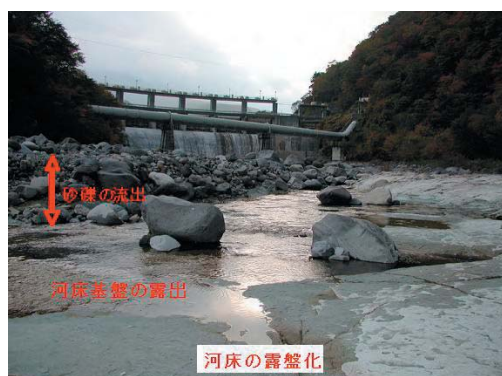
写真1 川底の露盤化
