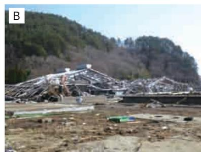
ろうじて形が分かる状態だが、壁はなくなり、鉛のように曲がった鉄骨だけになっていた。高さ数メートルの防潮堤は中央部から決壊したようだった(写真C)。防潮堤上部にある水門の開閉モーターにはがれきがからみついているので、津波の水位はそれ以上に達したようだ。
