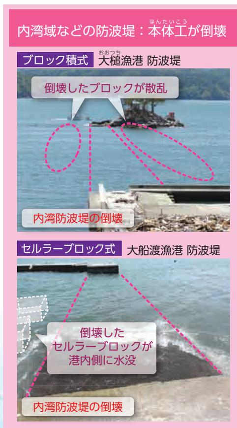
図1. 防波堤の被災事例
