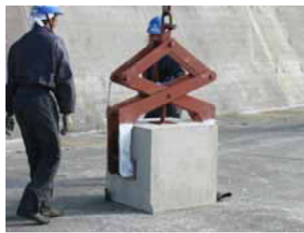
固化体ブロックの製作・設置
