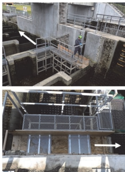
図 2. 信濃川宮中取水ダムに設置された魚カウンター。カメラ映像の自動撮影のために電極センサーが二組設置されています。映像撮影に際し、魚体の識別を容易にするために電極の下に塩化ビニル製板がはられています。白色矢印は流下方向を示します。
