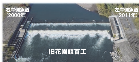
図 2. 旧花園頭首工の鳥瞰写真。花園頭首工として建設されたが、現在は農業用取水堰としての役割は終えたため、旧花園頭首工と呼ばれる。
