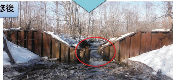
図 6. ポー川の落差工の改修。落差工をスリット化した(上:改修前, 下:改修後)。
