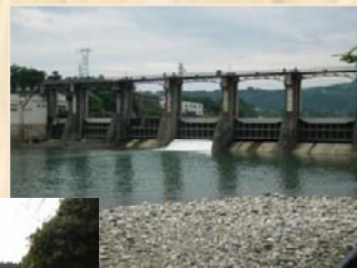
↑発電用の大型ダム
