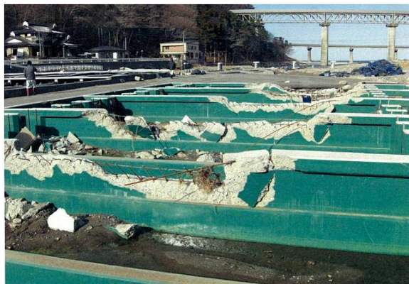
図 2. 津波によって破壊された下安家ふ化場。
