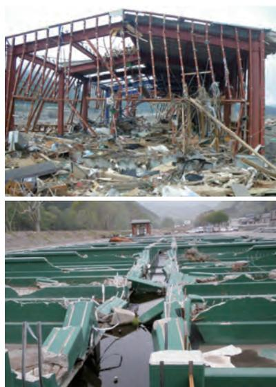
写真1 ふ化施設の被害状況
