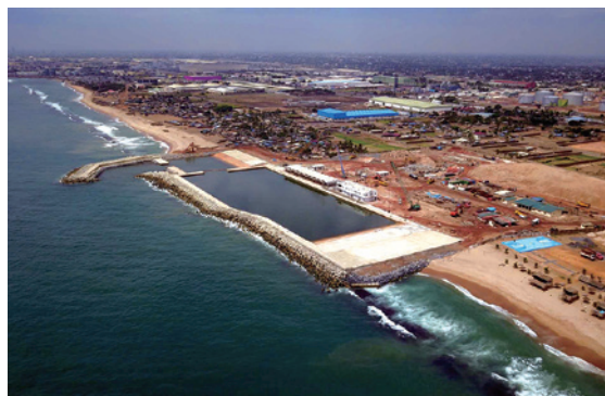
写真2 整備中の漁港
