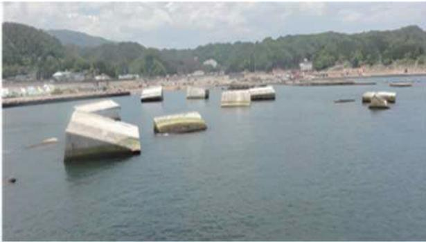
図 1. 津波で倒壊した防波堤の例(岩手県 田老漁港)
