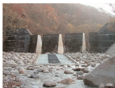
写真2. 露盤化対策のひとつ（堰堤のスリット化）
