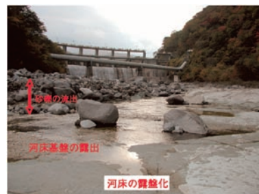
写真1. 河床の露盤化
