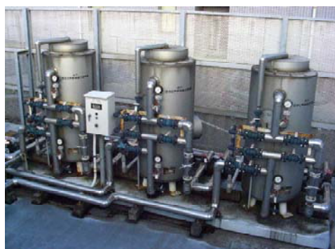
図4．使用した水の処理施設 淡水浄化槽（左）および汚泥脱水処理装置（右）
