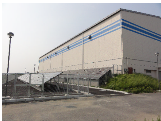
新設された太陽電池パネル
