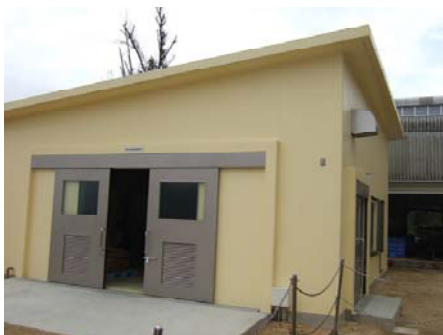
排水処理施設（西海区水産研究所）
