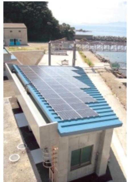
写真3 排水処理施設の太陽光発電設備の発電パネル
