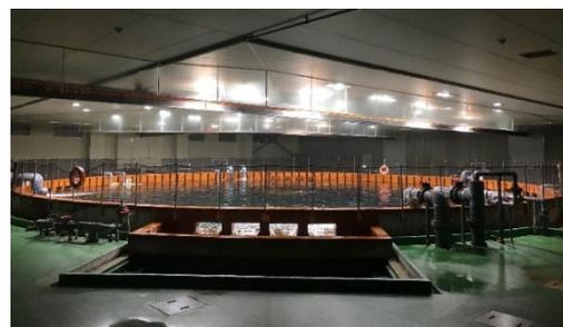
図1. 水温と日照時間の環境制御が可能な大型陸上水槽（直径20m、深さ6m、容積1,880m<sup>3</sup>）
