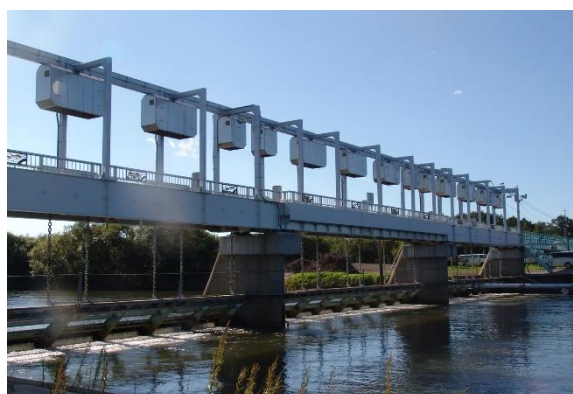
図 3. 標津川に設置されているウライ
